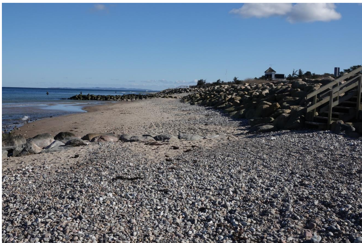
Højder og skræntbeskyttelse mellem Højde 2 og Højde 3 foran Rågeleje Strandpark, fotograferet 22. marts 2020 ved 7 cm lavvande.
